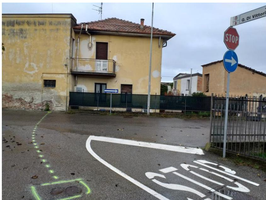
Figura 43: Tracciamento per lavori di chiusura di anelli di rete
